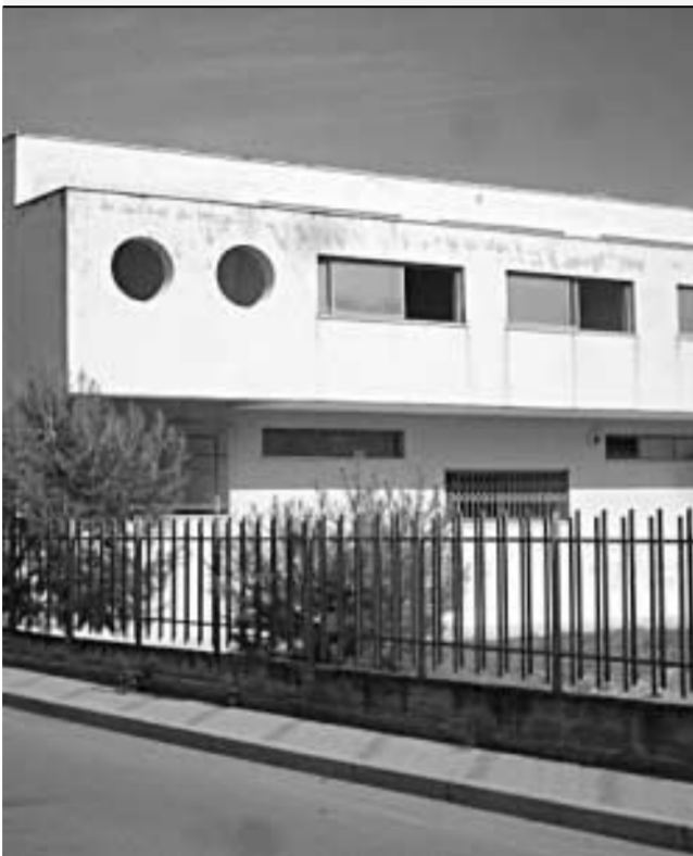
L'edificio. Il complesso scolastico di Nova Siri, costruito su suolo privato
