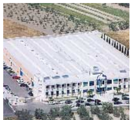
La sede. Fabbrica e uffici della Igam, a Canosa
