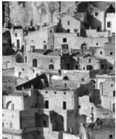
I risultati. Abitazioni recuperate nella zona dei Sassi
