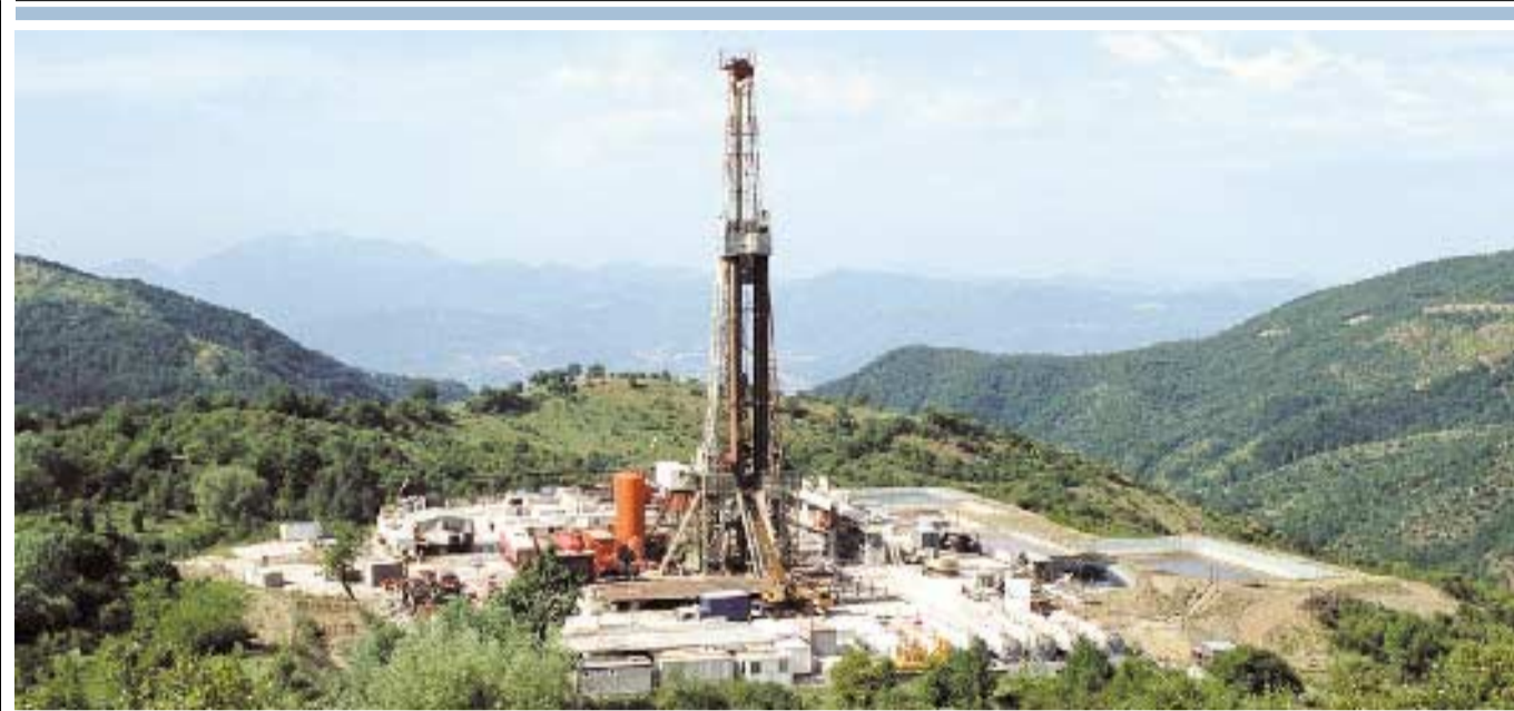
Perforazioni. Un pozzo petrolifero dell'Eni in Val d'Agri e, sotto, il Centro Olio a Viggiano, in provincia di Potenza
