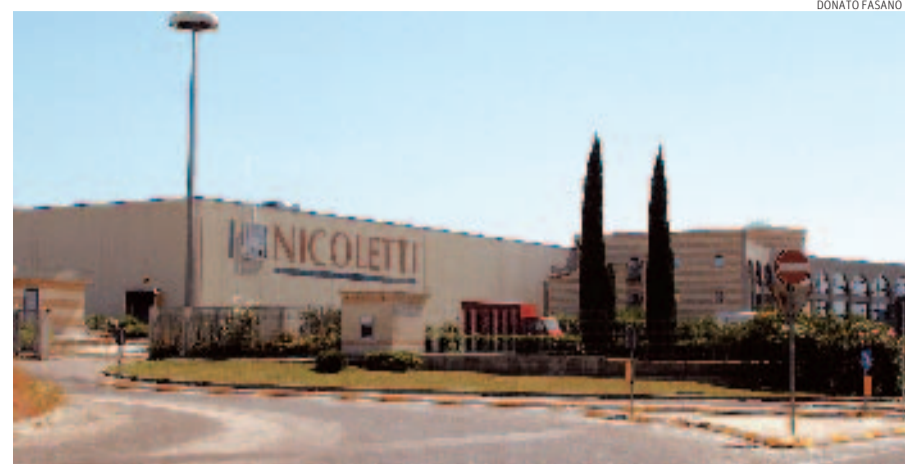
Chiuso. Lo stabilimento della Nicoletti a Matera, realizzato dieci anni fa e costato 25 milioni di euro
